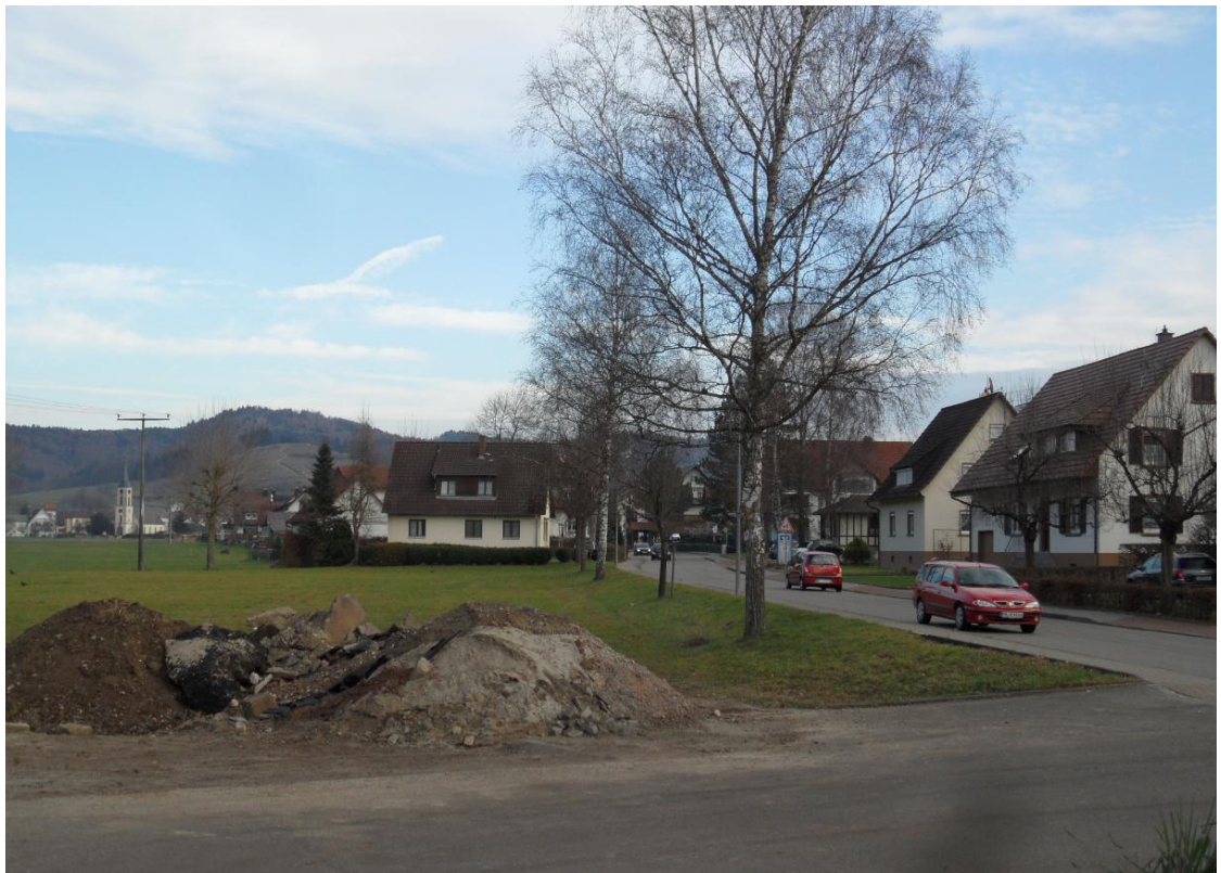
Foto: Änderungsgebiet im Bereich der Bebauung mit L 110 vor Errichtung des bereits fertiggestellten Neubaus
