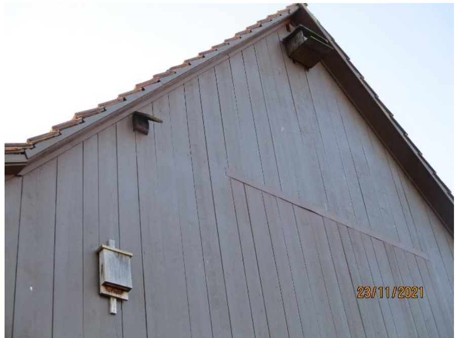
Abb. 16: Turmfalkennistkasten und Fledermauskasten an einer Scheune
