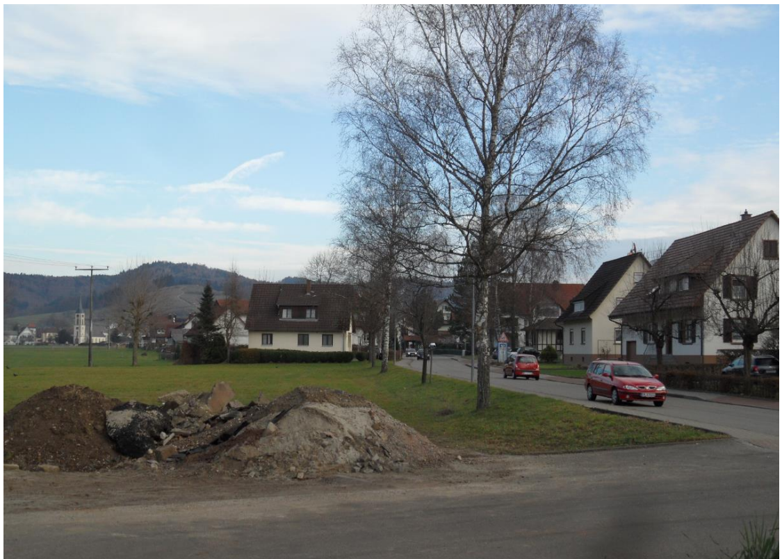
Foto: Änderungsgebiet im Bereich der Bebauung mit L 110 vor Errichtung des bereits fertiggestellten Neubaus Aufnahmedatum: 15.12.2015 (Blickrichtung Nord-Osten)
